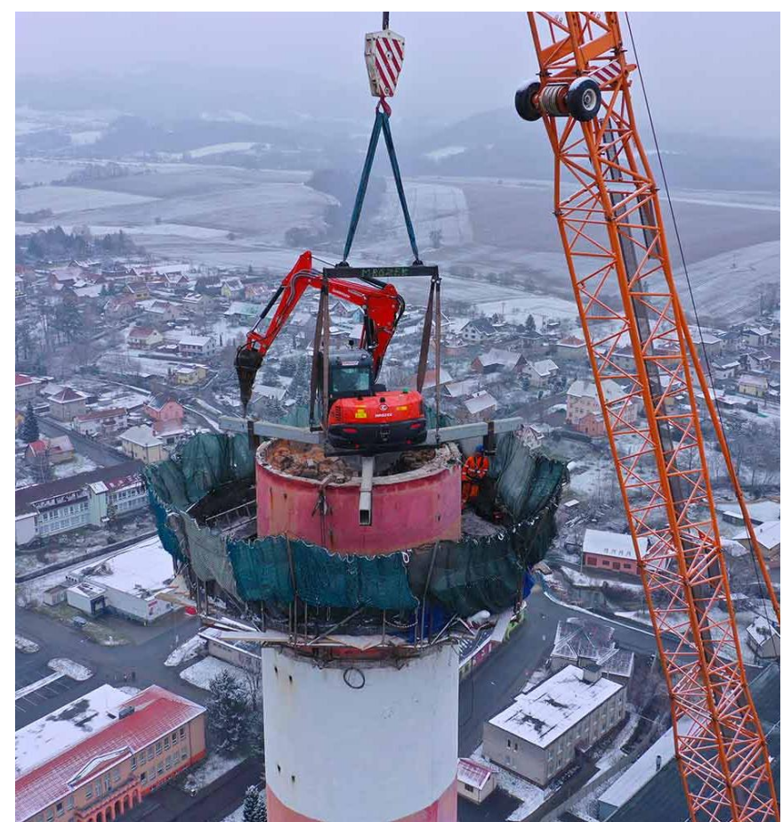
Bourání komínu firmou MROZEK
